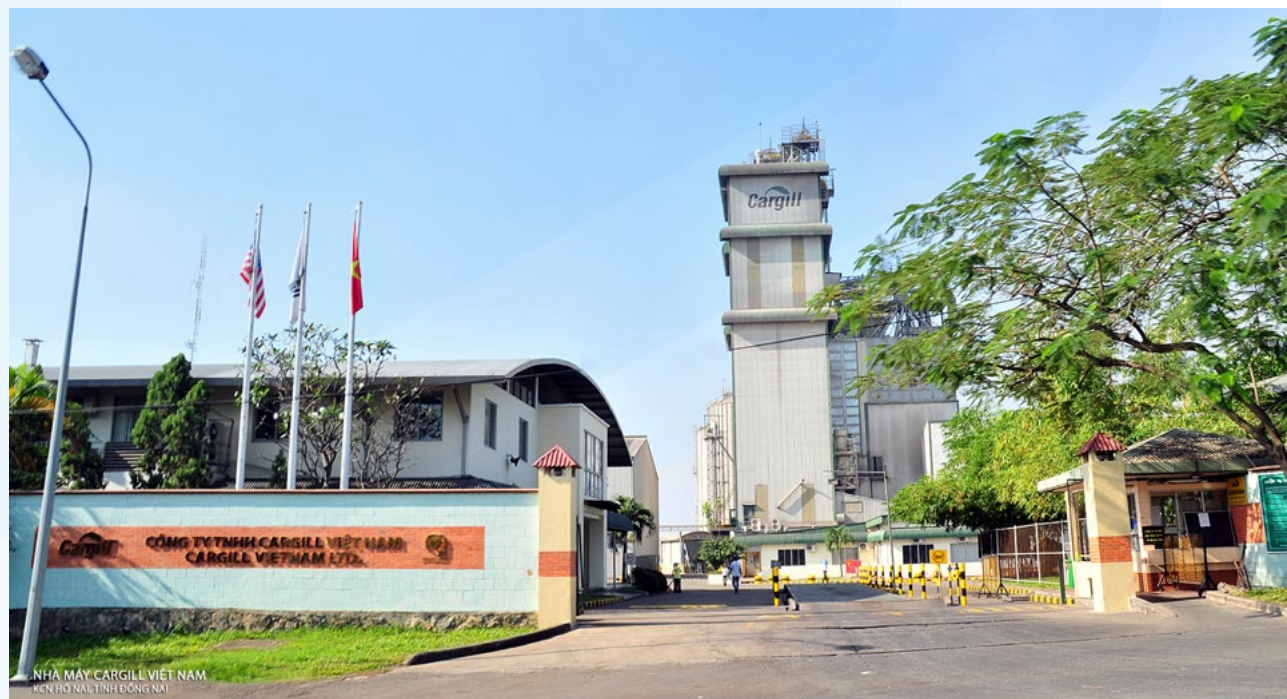
越南CARGILL 饲料工厂
